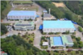
Fábrica de Cheonan (Corea) PLC, variador de frecuencia, HMI, DCS, módulo fotovoltaico
