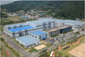
Fábrica de Busan (Corea) HV TR, HVDC, HECHOS
